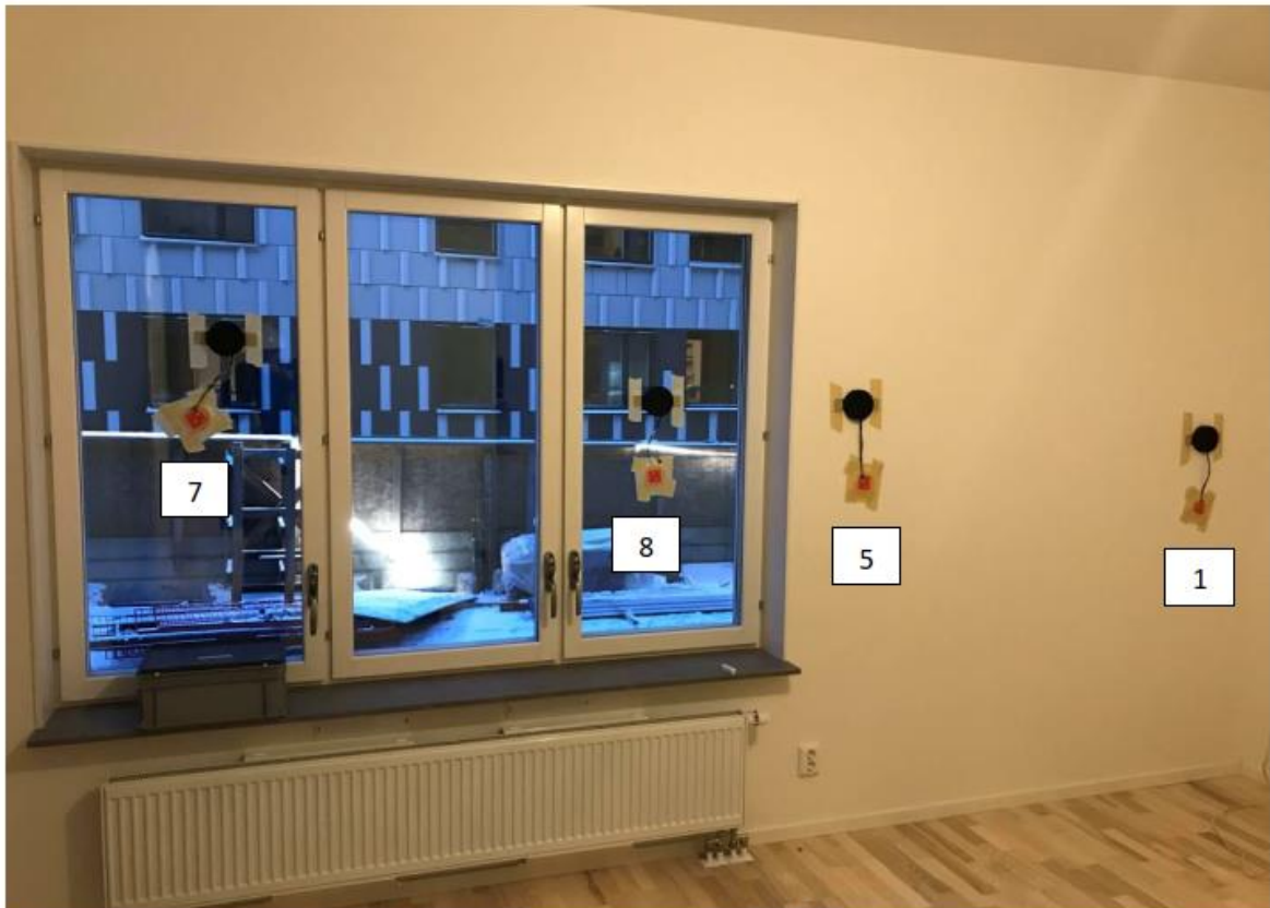
2 st mätare monterades på fönster i vardagsrummet. Samt 2 st på ytterväggen
