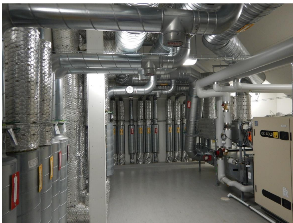
Figur 3.9 Fläktrum hos Vätterhem, där luftflödena enkelt justeras in till och från varje lägenhet samt mäts med litet fel. Detta underlättar och snabbar upp luftflödesmätningarna för injustering och kommande OVK, då det mesta finns tillgängligt i fläktrummet.
